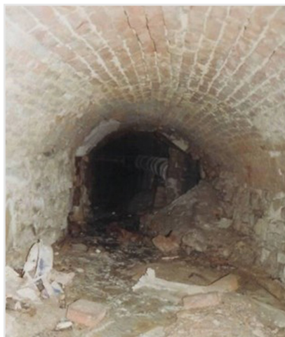
Ursprüngliches Krottenbachgewölbe unterhalb Hameaustraße 5
