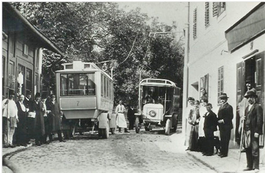
Gleislose Straßenbahn an der Engstelle, bei Neustift am Walde 88
